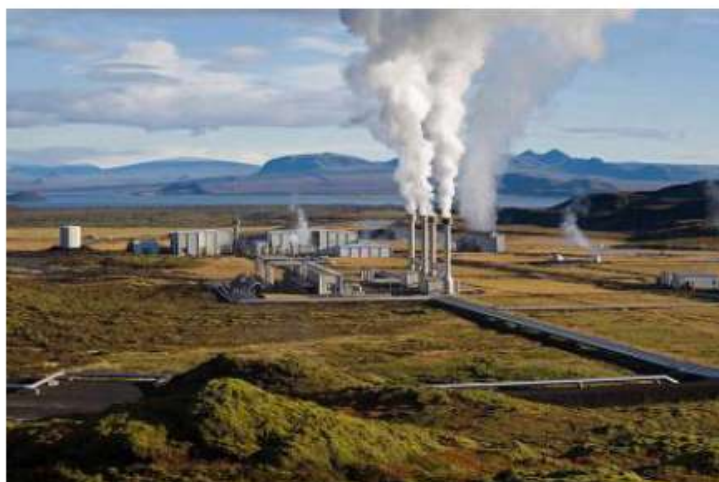
Nesjavellir, Islandija – geotermalna elektrarna
