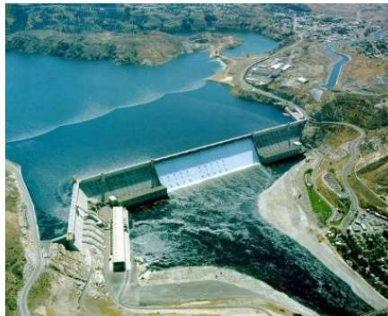
Grand-Coulee-Talsperre, ZDA, 1974, 6.809 MW
