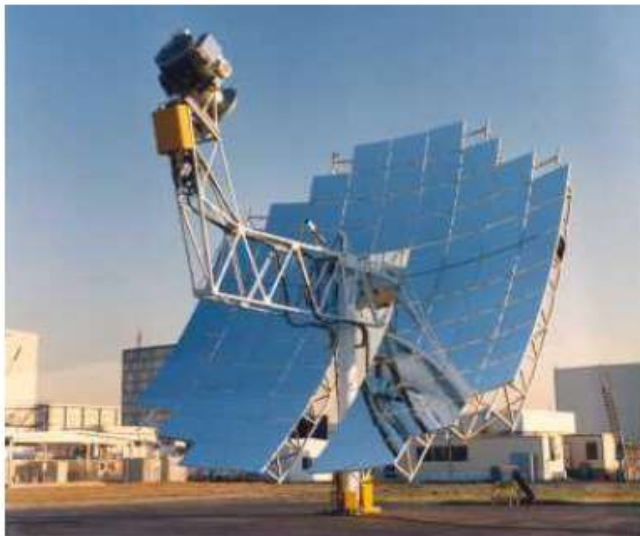
Maricopa Solar, Arizona, ZDA, ZDA, 1,5 MW
