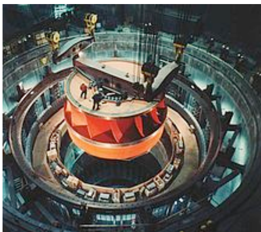
Slika: Francisova vodna turbina Vir: Wikipedija
