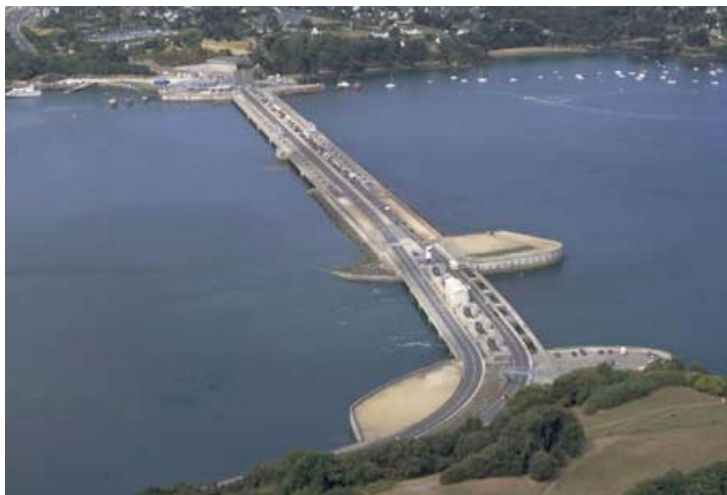
Slika: Elektrarna na reki Rance
