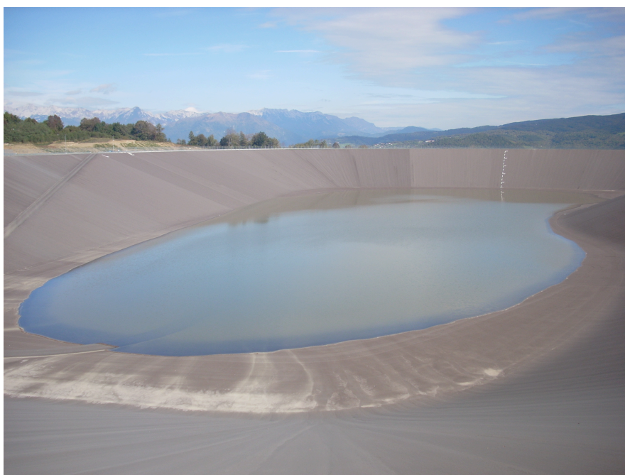
Slika: Črpalna hidroelektrarna Avče
