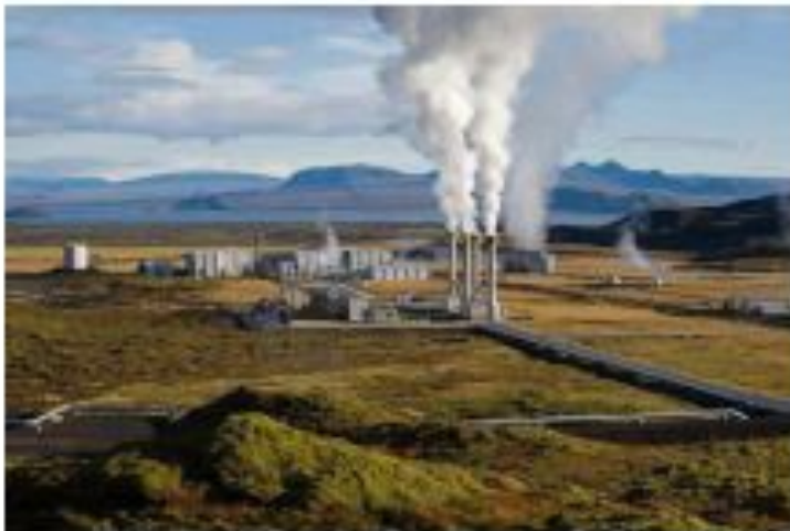
Nesjavellir, Islandija – geotermalna elektrarna
