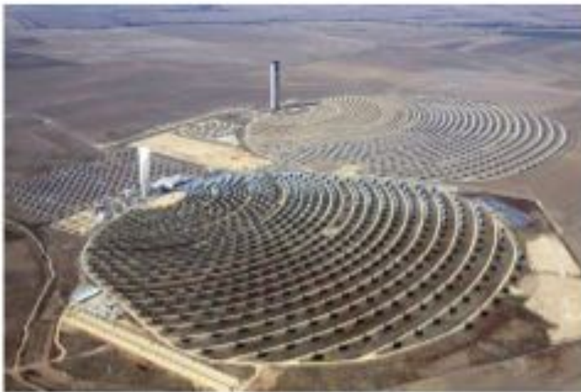
Planta Solar 10, Andaluzija, Španija, 10 MW
