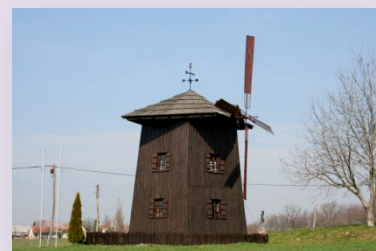
Slika: Mlin na veter v Slovenskih goricah, ponovno postavljen na starih temeljih
