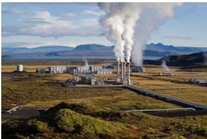
Nesjavellir, Islandija – geotermalna elektrarna
