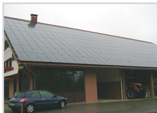
Sončna elektrarna Košir 67 kW, Polhov Gradec
