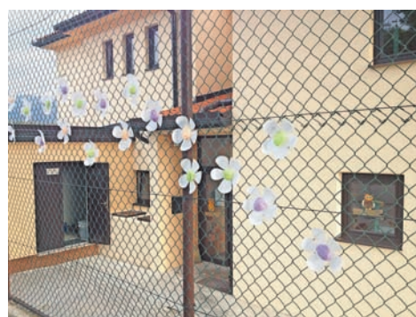
Energetsko sanirana Podružnična osnovna šola Trnovo z novo kotlovnico na biomaso Foto GOLEA
