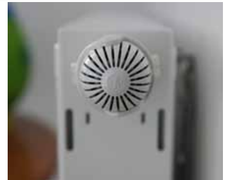
Nov radiator s termostatskim ventilom in zaščito za nadzorovano reguliranje temperature • foto GO-TV
