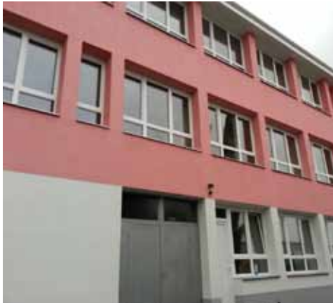
Energetsko sanirana stavba italijanske šole Vincenzo e Diego De Castro v Sečovljah • foto GOLEA
