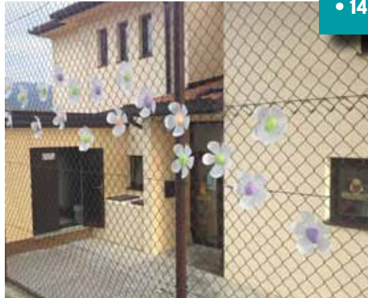
Energetsko sanirana stavba in kotlovnica na lesno biomaso solkanske podružnične šole v Trnovem nad Novo Gorico • foto GOLEA
