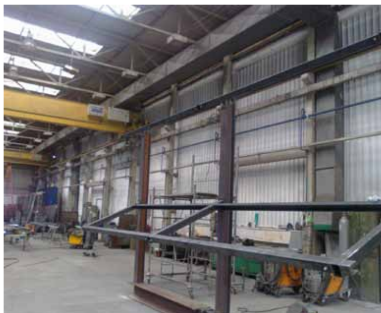
Gradnja posebne konstrukcije za panele, da je primerna tudi za zelo močno burjo • foto ADRIAPLAN - JADRAN
