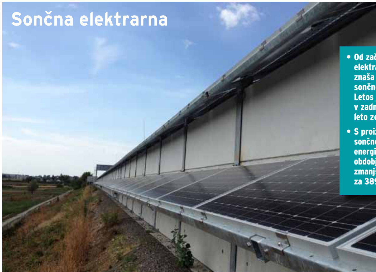
Sončna elektrarna na protihrupni ograji • foto GOLEA
