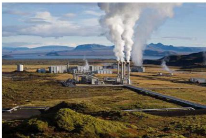
Nesjavellir, Islandija – geotermalna elektrarna
