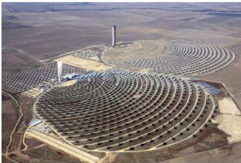
Planta Solar 10, Andaluzija, Španija, 10 MW
