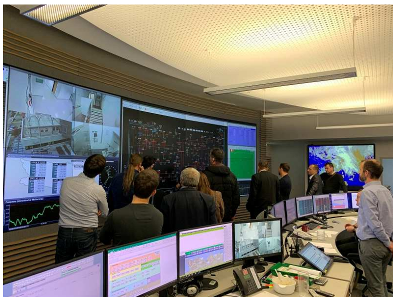
Slika / Bild 8: Ogled dobre prakse podjetja Kelag Centrala v Celovcu / Besichtigung der Kelag Schaltzentrale in Klagenfurt (Avtor / Autor: Ivana Kacafura, GOLEA)
