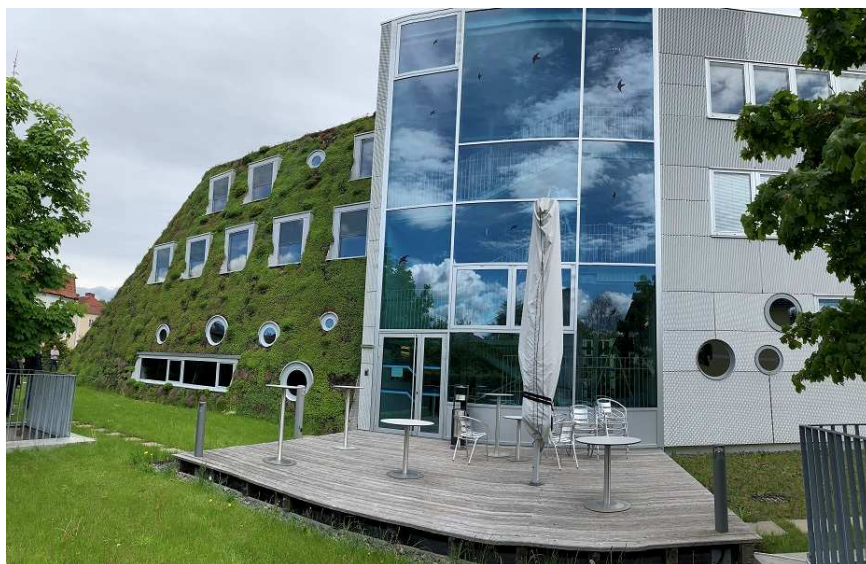
Slika / Bild 2: Ogled energetsko zelene in varčne stavbe AUVA Klagenfurt, maj 2019 / Besichtigung des energieeffizienten und grünen Ökogebäudes AUVA Klagenfurt im Mai 2019
