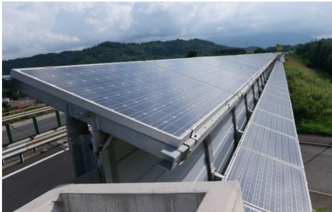
Protihrupna ograja H4 – Vrtojba (2012, SE na degradiranem območju)
